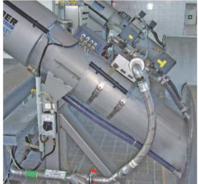
Kanale įrengtas ROTAMAT® būgninis nešmenų šalinimo įrenginys Ro 1 su integruota nešmenų plovimo sistema IRGA.
