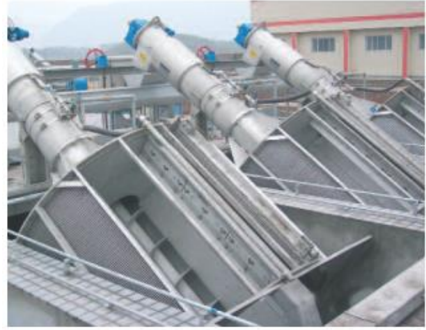
Keli kanale lygiagrečiai įrengti ROTAMAT® būgniniai nešmenų šalinimo įrenginiai.
