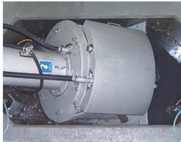
ROTAMAT® būgninis nešmenų šalinimo įrenginys Ro 1 su apsauga nuo taškymosi.
