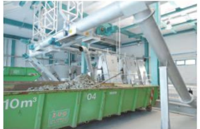
HUBER ROTAMAT® sraigtinis konvejeris Ro 8t iškrauna nešmenis.
