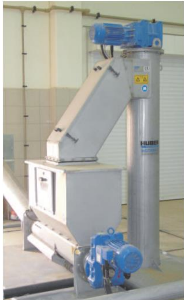
Vertikaliai sumontuotas sraigtinis konvejeris, iškraunantis nešmenis į HUBER nešmenų plovimo presą.
