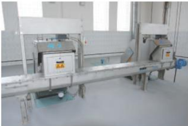
Du lygiagrečiai įrengti įrenginiai iškrauna nešmenis į vieną sraigtinį konvejerį.
