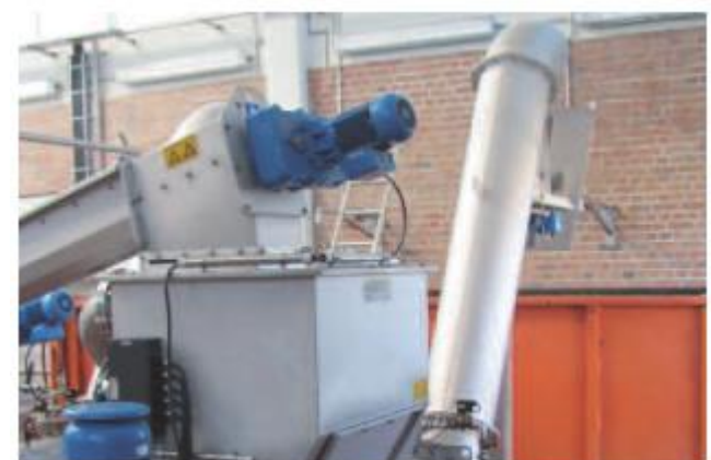
HUBER ROTAMAT® sraigtinis konvejeris Ro 8t iškrauna nešmenis į HUBER nešmenų plovimo presą WAP/SL.
