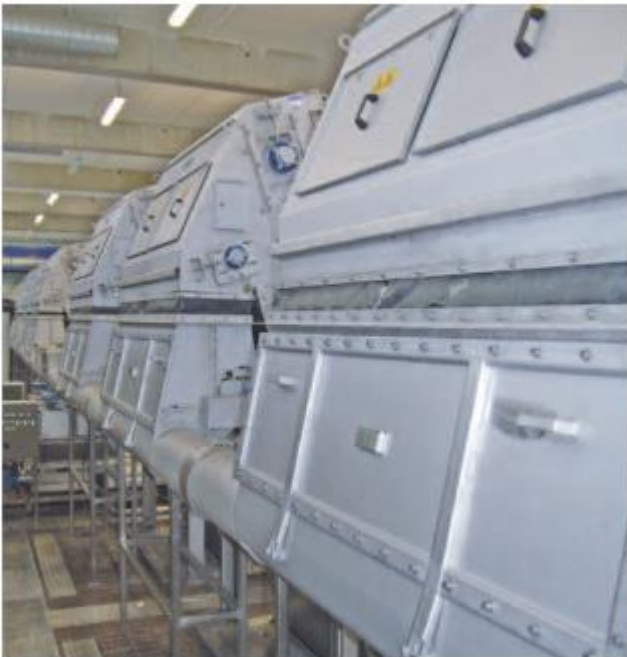
HUBER perforuotos grotos EscaMax® su toliau esančiu plovimo kanalu sklandžiam nešmenų gabenimui. Vaizdas iš galo.
