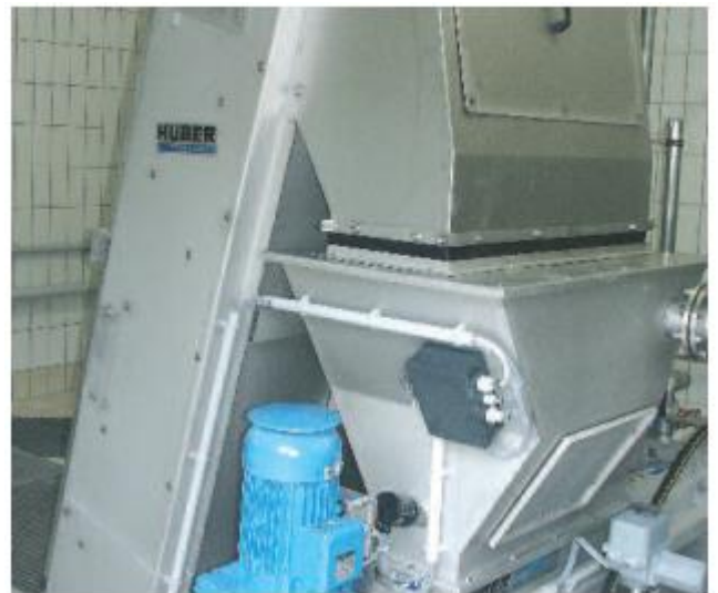
HUBER RakeMax® vertikalių grotų su toliau esančiu nešmenų plovimo presu WAP/SL. Vaizdas iš galo.
