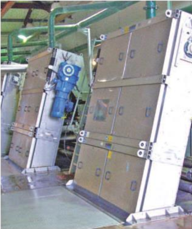
Universaliai naudojamos HUBER RakeMax® vertikalių grotų esant didelio pločio kanalams...
