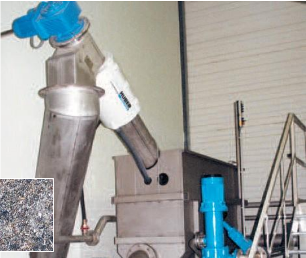
ROTAMAT® tankus filtras 1 mm nešmenims ir organinių medžiagų nusausinimui (apie 30% DR)
