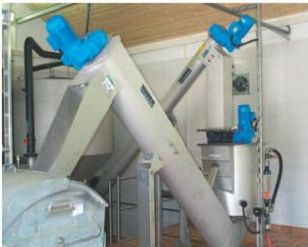
HUBER smėlio plovimo įrenginys RoSF 4/t plauna atskirtą smėlį iš HUBER apvalios smėliagaudės HRSF.
