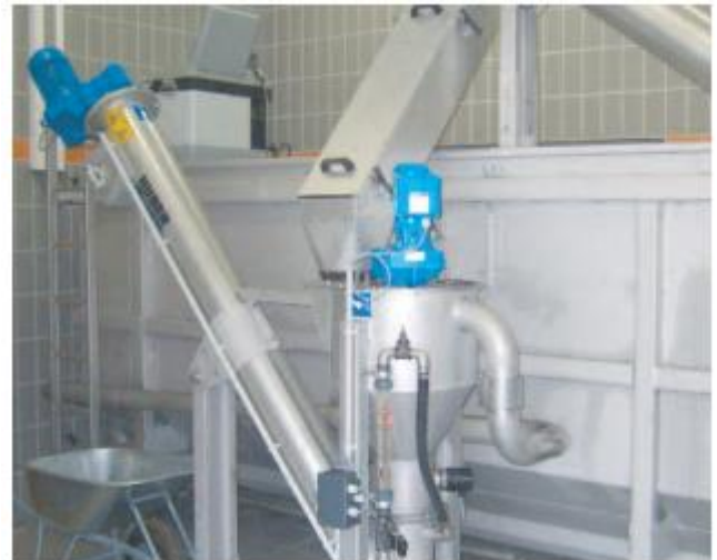
Mažas HUBER smėlio plovimo įrenginys RoSF 4/t plauna atskirtą smėlį iš ROTAMAT® pilnutinio valymo įrenginio Ro 5.
