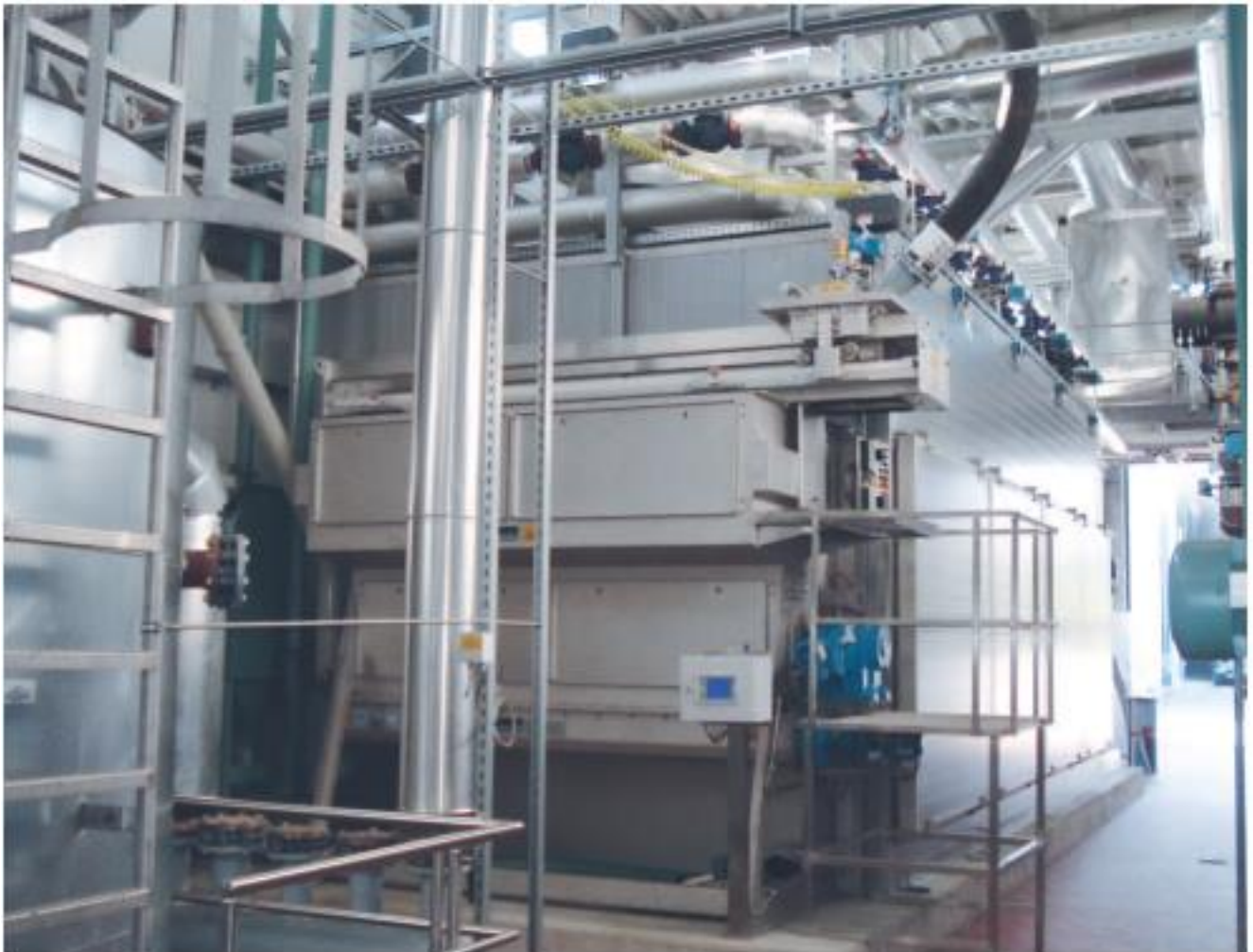
HUBER juostinis džiovavimo įrenginys BT: šlapias dumblas tiekiamas per granuliavimo įrenginį, sausa medžiaga iškraunama horizontaliu šalinimo sraigtu.
