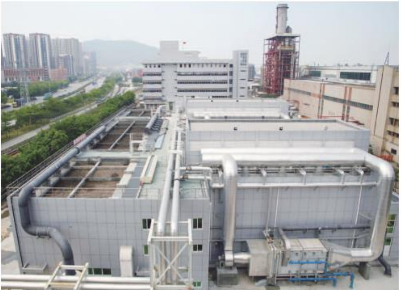
Didelio masto nuotekų dumblo džiovinimo įrenginiai su išoriniais kondensatoriniais agregatais ir biofiltrais.
