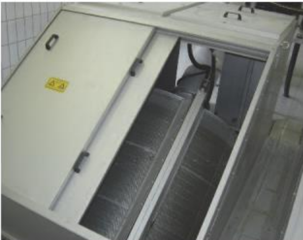
Kanale sumontuotas ROTAMAT® būgninis nešmenų šalinimo įrenginys su besisukančiu būgnu Ro 2 su slankiu nerūdijančio plieno dangčiu, dydis 600 – 3000.
