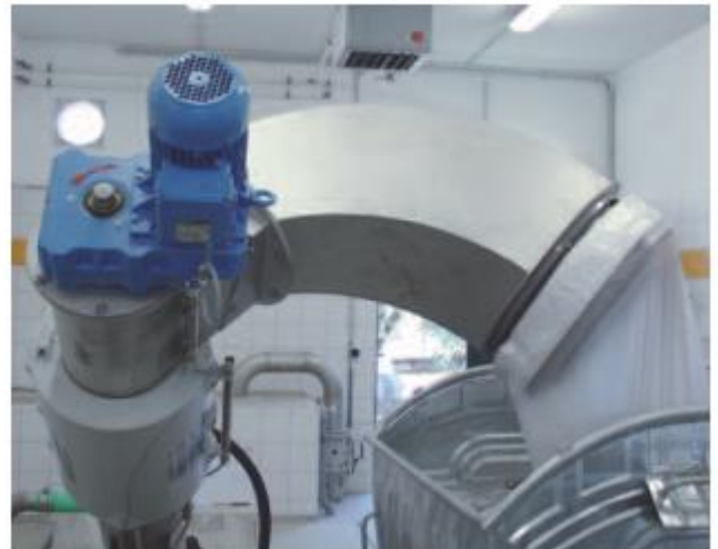
Individualus įrenginio įrengimas su šoniniu nešmenų iškrovimu tiesiai į konteinerį.
