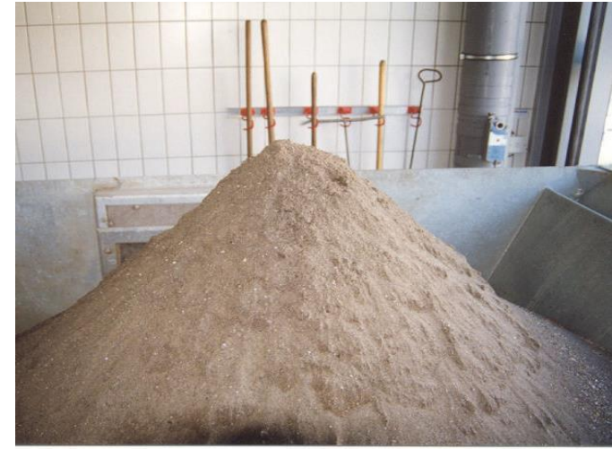
Atskirtas ir išvalytas smėlis „Huber“ smėlio plovimo įrenginyje Freystadt mieste
