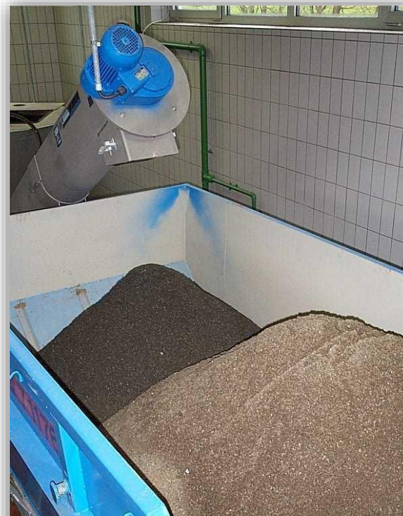
Išrūšiuotas plautas smėlis iš smėlio plovimo įrenginio
