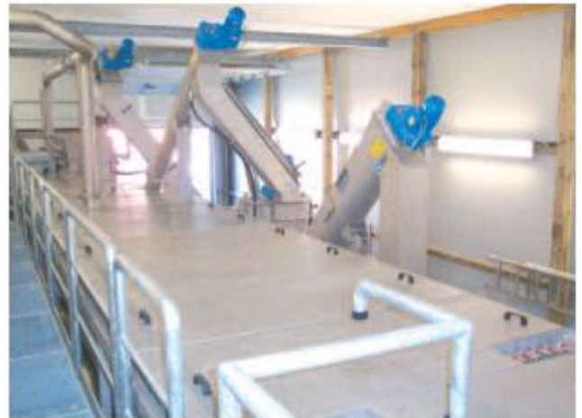
Uždaras, kvapų neskleidžiantis nešmenų iškrovimas iš ROTAMAT® pilnutinio valymo įrenginio Ro 5.
