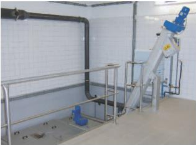
Integruota smėlio plovimo sistema ROTAMAT® pilnutinio valymo įrenginio Ro 5 gale.
