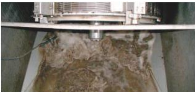
Pripažintas nuotekų valymo įrenginys: ROTAMAT® būgninis nešmenų šalinimo įrenginys su besisukančiu būgnu Ro 2.
