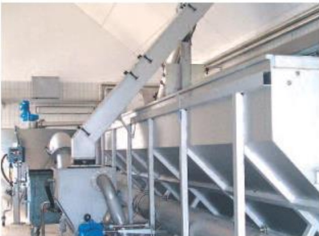
Intensyvus nešmenų plovimas WAP/SL nešmenų plovimo prese, įrengtame už ROTAMAT® pilnutinio valymo įrenginio Ro 5.
