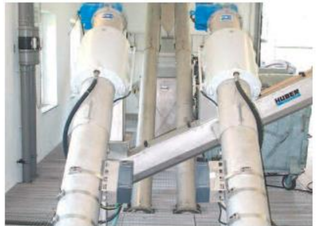
Po žeme sumontuotas atsarginis ROTAMAT® pilnutinio valymo įrenginys Ro 5.
