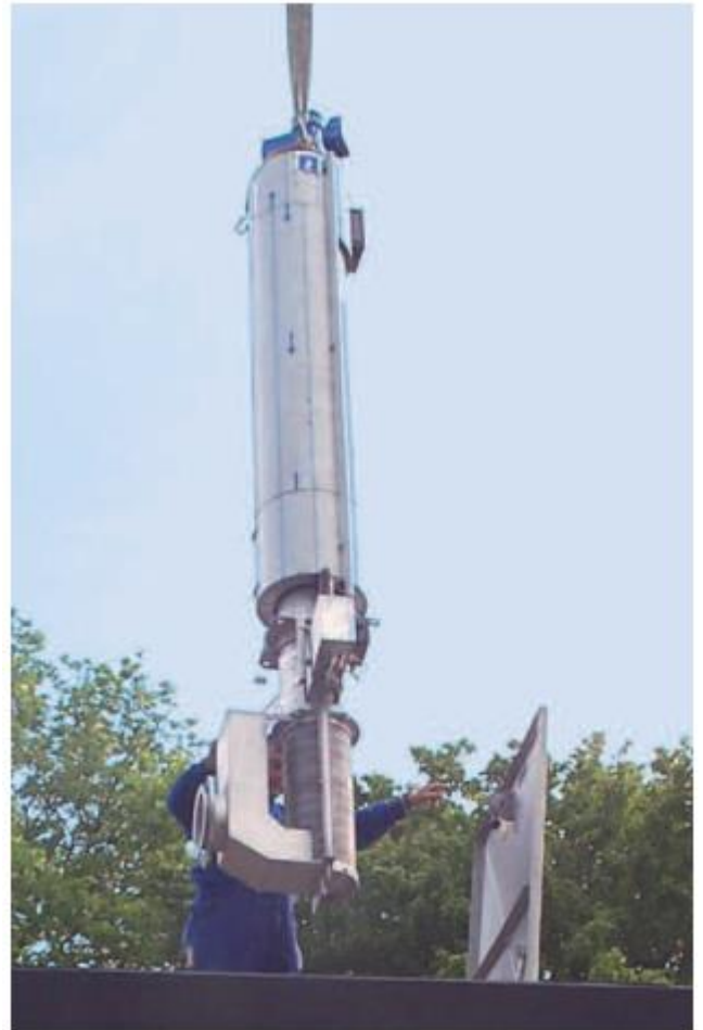
ROTAMAT® RoK 4 grotos su vertikaliu sraigtu perpumpavimo stotims įkeliama į perpumpavimo stotį
