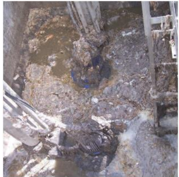
Siurblių užsikimšimas dėl gabenamoje terpėje esančių kietųjų dalelių
