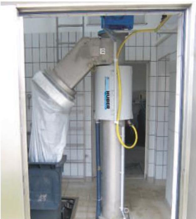
Nešmenys iškraunami į pakavimo į maišus įrenginį neskleidžiant kvapų.
