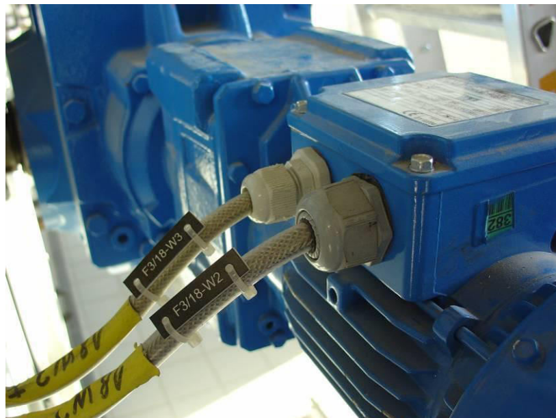
Kabelių įrengimas (pavyzdys)
