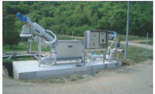
Pripažintos mechaninio pirminio valymo sudedamosios dalys viename ROTAMAT® septiko priėmimo įrenginyje Ro 3.3.
