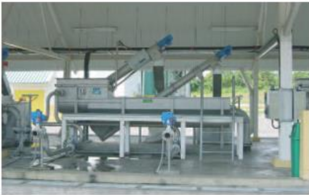
ROTAMAT® septiko priėmimo įrenginys su neaeruojama smėliagaude ir integruotu smėlio šalinimo sraigtu.
