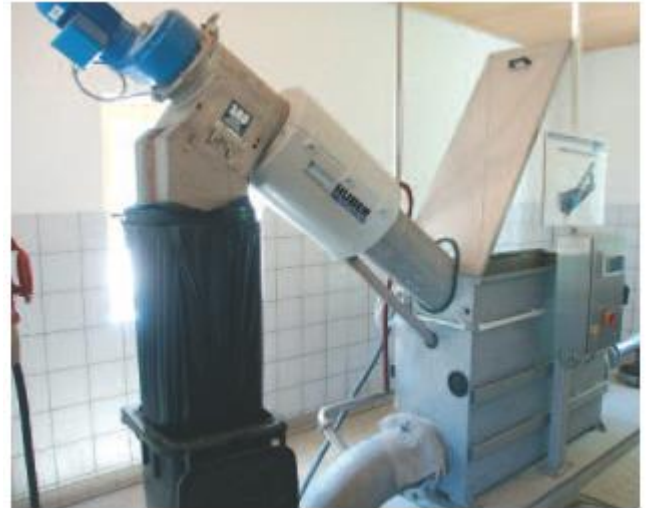
Rezervuare sumontuotas ROTAMAT@ mikro koštuvas Ro 9.
