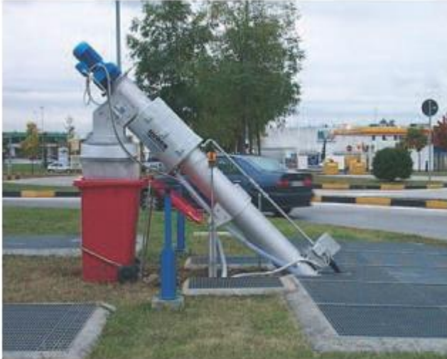
ROTAMAT@ mikro koštuvas Ro 9, sumontuotas transporto žiedo viduryje.
