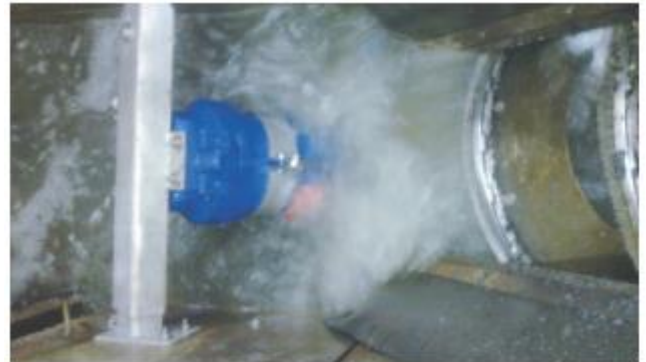
Išorinė nešmenų plovimo sistema (ERGA). Pirmiau esanti plovimo sistema išplauna organines medžiagas.
