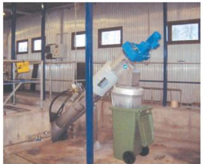
Kanale sumontuotas ROTAMAT@ mikro koštuvas Ro 9, dydis 700.
