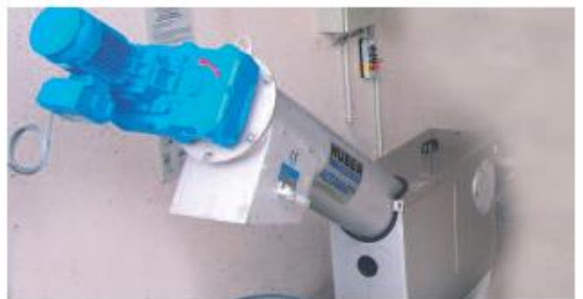
Rezervuare sumontuotas ROTAMAT® Mikro koštuvas Ro 9Ec.
