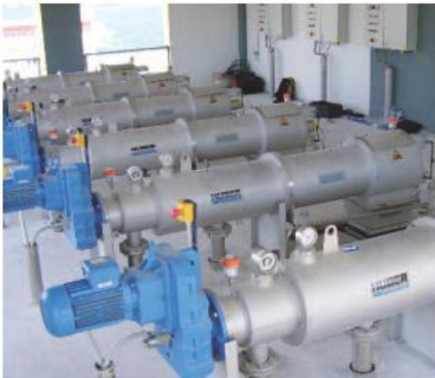
Dumblo filtravimas NVJ Atėnuose, Graikijoje.
