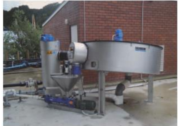
Lauke sumontuotas ROTAMAT® diskinis dumblo tankinimo įrenginys RoS 2S.
