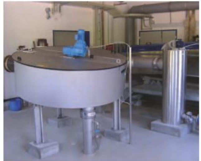
ROTAMAT® diskinis dumblo tankinimo įrenginys RoS 2S, dydis 2, su prieš jį įrengtu flokuliacijos reaktoriumi.
