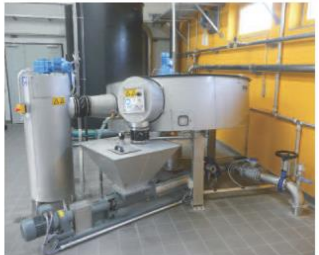
ROTAMAT® diskinis dumblo tankinimo įrenginys RoS 2S, 35 m 3 /h tankinanti konstrukcija.
