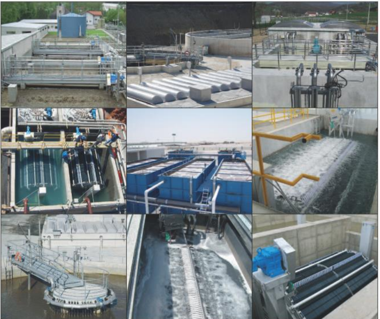
HUBER VRM® membraniniai bioreaktoriai naudojami pramoninių ir municipalinių nuotekų centralizuotuose ir decentralizuotuose valymo įrenginiuose.
